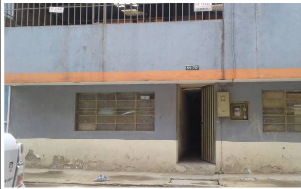
Foto No. 1 Fachada del establecimiento
